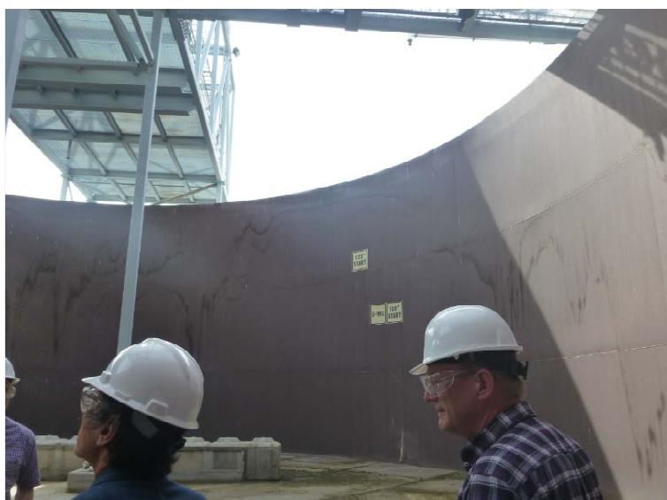
モックアップ施設内観 (上部のクレーンによる遠隔操作の模擬試験等を行った。)
