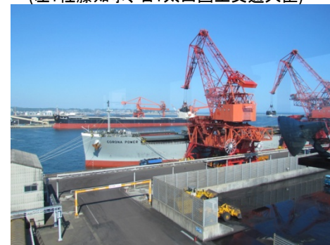
小名浜港 7号ふ頭荷役状況
