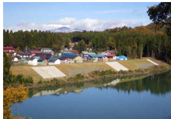
完成した堤防の様子
