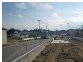
道路改良工事状況
