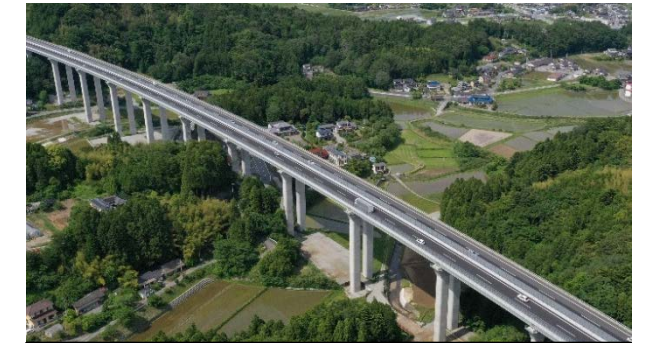
常磐自動車道(いわき中央IC~広野IC) 令和3年6月13日 4車線運用開始
