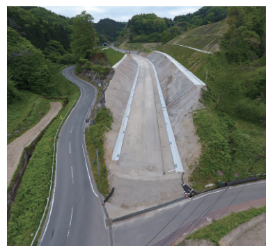
ふくしま復興再生道路(国道349号)
