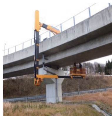
橋梁点検(あぶくま高原道路)
