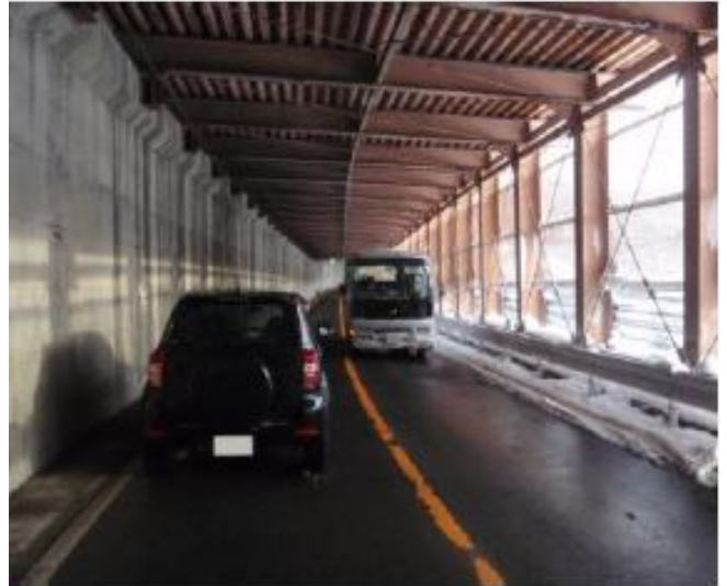
全面供用の状況
