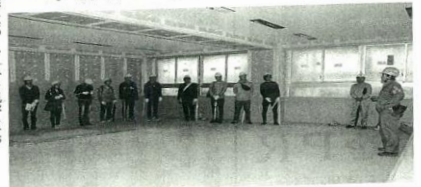
改築中の校舎で説明を受ける学生ら
