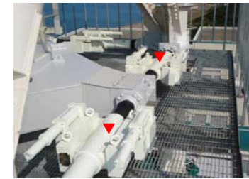
制震オイルダンパー設置イメージ
