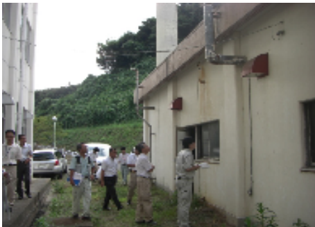
(災害査定現地調査の様子)
