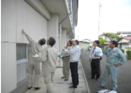
(災害査定現地調査の様子)
