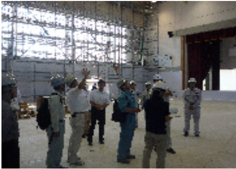
(災害査定現地調査の様子)
