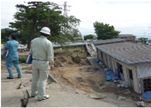
(災害査定現地調査の様子)
