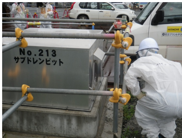
○サブドレンピット（建屋周辺の井戸）確認の様子
