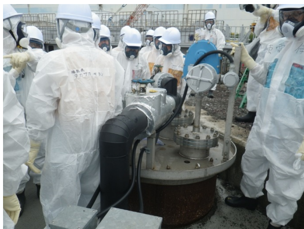
○地下水ドレンポンド（護岸付近の大きな井戸）確認の様子
