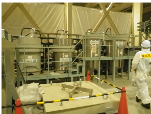
○浄化処理設備確認の様子
