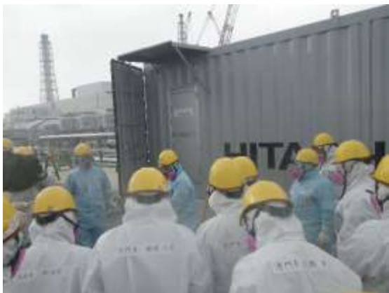
地下水ドレン前処理設備の説明を現場で受けている様子
