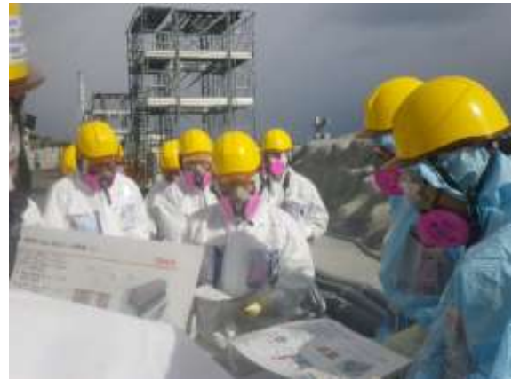
3号機原子炉建屋燃料取り出し用カバー設置状況を現地確認している様子
