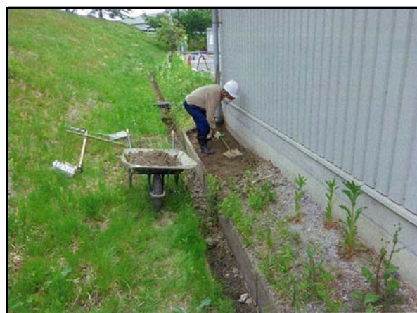
除染(表土剥ぎ取り)
