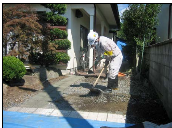
砂利・碎石の除去
