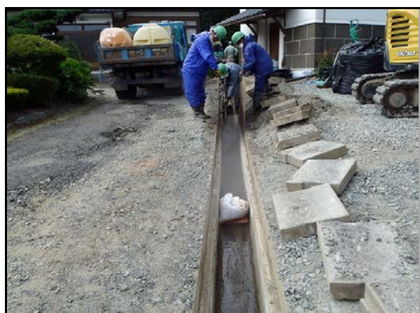
側溝の高圧洗浄
