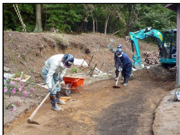
住宅周りの表土除去
