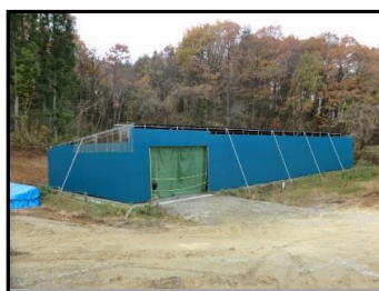
石川町仮置場
