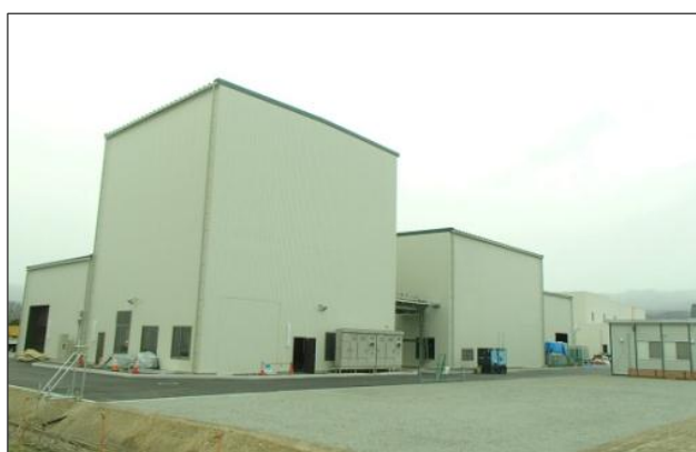
仮設汚泥乾燥施設全景
