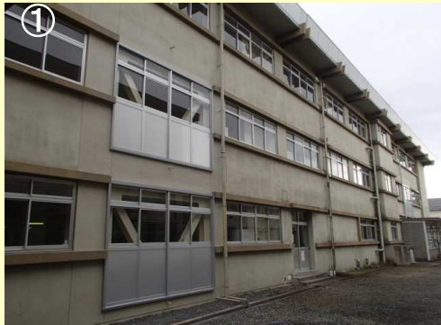
路線名：白河高校 事業名：白河高校耐震改修工事 場所：白河市南登り町地内 工事説明：校舎の耐震化を図るため壁の増設やブレースを設置し耐震性能を向上し、安全で良好な教育環境の提供を図ります。
