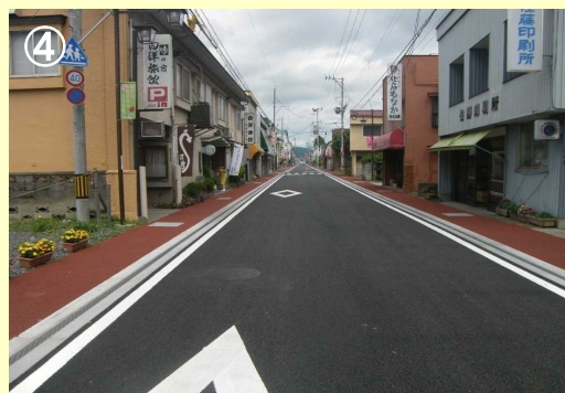
路線名：塙大津港線 事業名：元気ふくしま地域づくり交流促進事業 場所：東白川郡塙町大字塙地内 工事説明：塙町中心市街地活性化基本構想と本町地区の地域づくりを支援するため、塙大津港線の歩道部段差解消、歩道内の電柱移転、案内看板(サイン)の整備を進めています。
