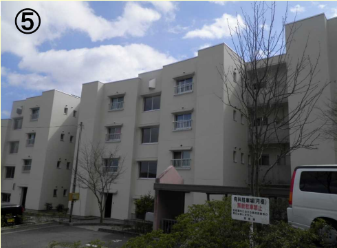
路線名：県営住宅関川窪地 事業名：県営住宅改善工事(外壁・屋上防水改修) 場所：白河市関川窪地内 工事説明：外壁に断熱材をはり、屋上の防水性の向上を図り、より快適で安心な住環境の提供を図ります。
