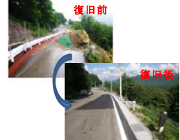
関東・東北豪雨復旧状況(駒止峠)
