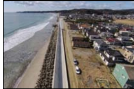
関田地区海岸堤防 (完成 H28.3)
