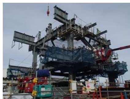
写真③ 5段目ユニット地組
