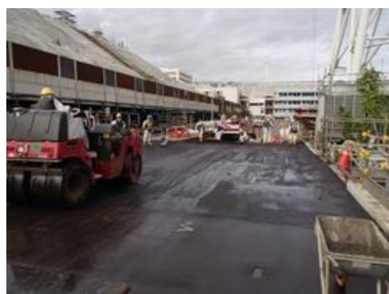
写真② アスファルト舗装中
