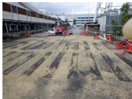
写真① 路盤砕石敷設完了
