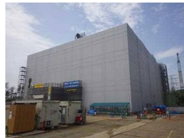
雑固体廃棄物焼却設備（建屋全景）
