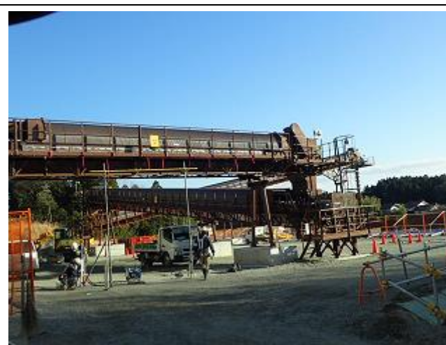
双葉工区土壌貯蔵施設の状況の確認
