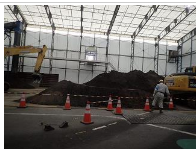
大熊工区受入・分別施設の状況の確認
