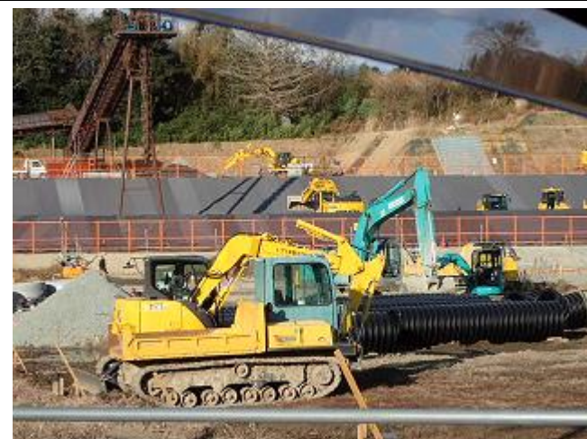
双葉工区土壌貯蔵施設の状況の確認
