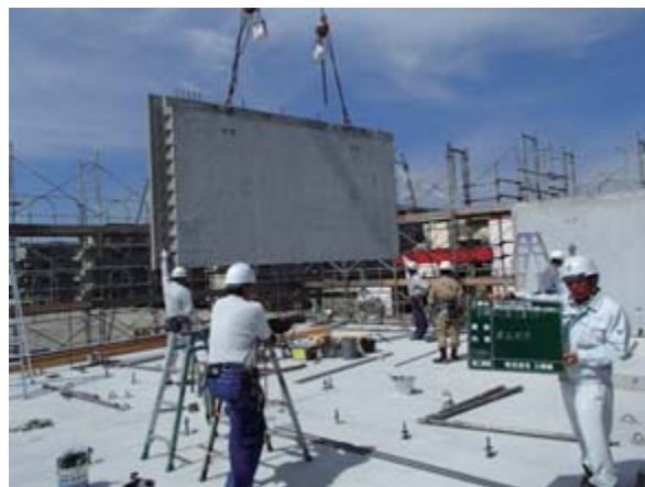
PC建込み状況
