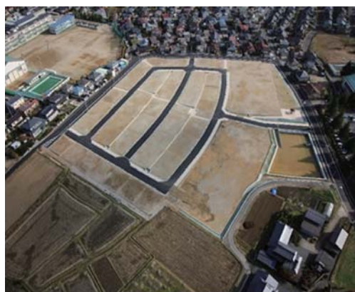
造成工事完了後
