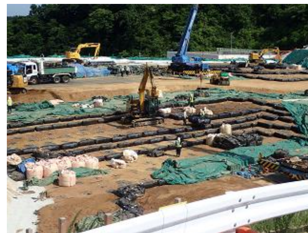
下流側埋立地の埋立状況の確認
