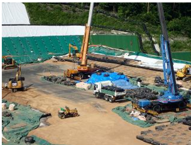
下流側埋立地の埋立状況の確認
