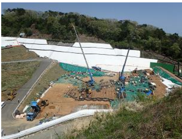
下流側埋立地の埋立状況の確認
