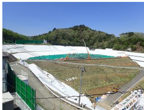
上流側埋立地の埋立状況の確認
