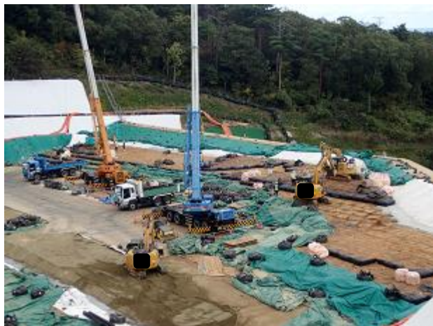
下流側埋立地の埋立状況の確認
