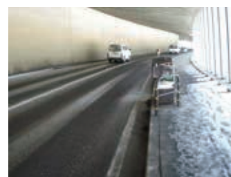
凍結抑制剤自動散布機の散布状況
