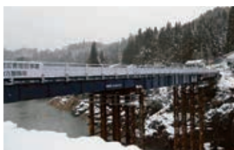
H23.12.20応急復旧完了 (仮橋供用開始)
