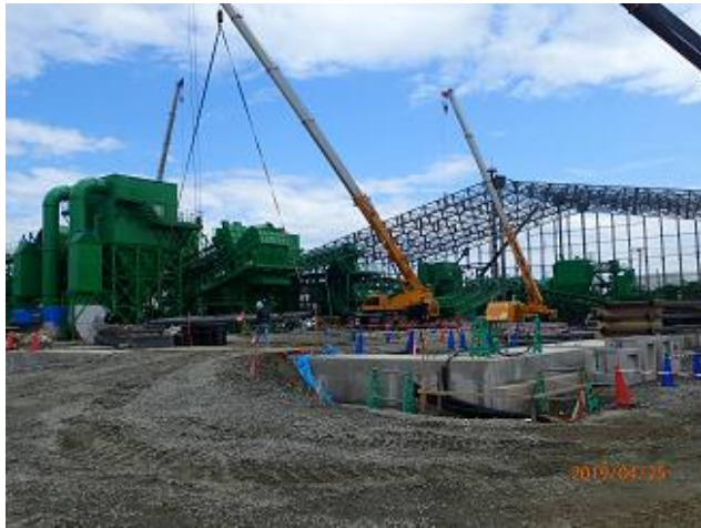
受入・分別施設の設置状況の確認
