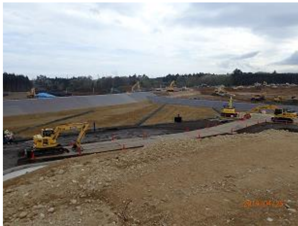
土壌貯蔵施設の稼働状況の確認
