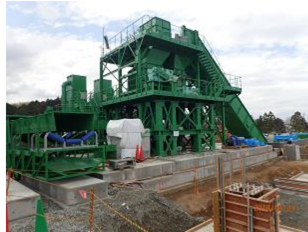
受入・分別施設の設置状況の確認
