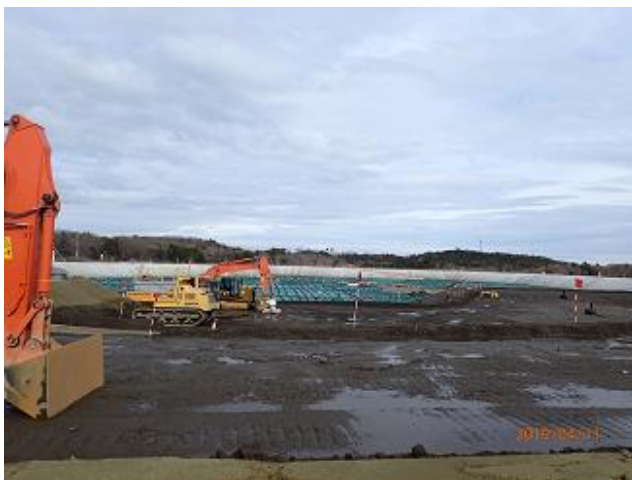
土壌貯蔵施設の稼働状況の確認
