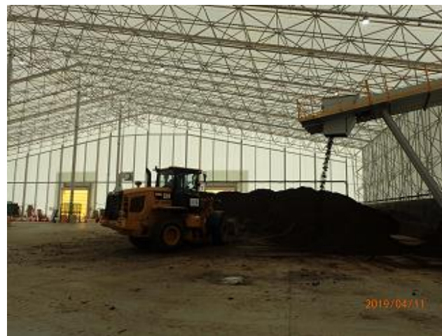
処理土壌中継ヤードの稼働状況の確認
