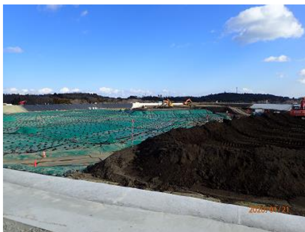
土壌貯蔵施設の稼働状況の確認
