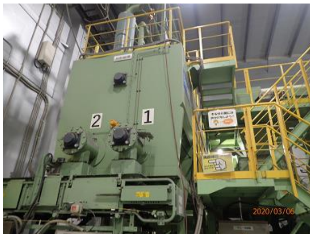
固型化施設(灰貯留槽)の確認
