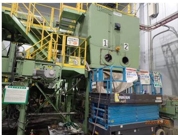
固型化施設(灰貯留槽工事部分)の確認
