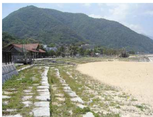
自然素材を活かした階段護岸 < 出典：海岸景観形成ガイドライン >
