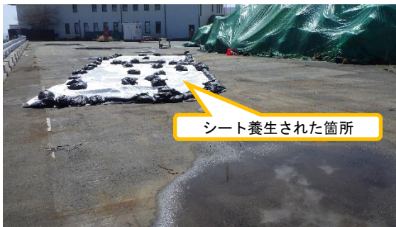
(写真1) 瓦礫一時保管エリアW2 (北東側から撮影)
