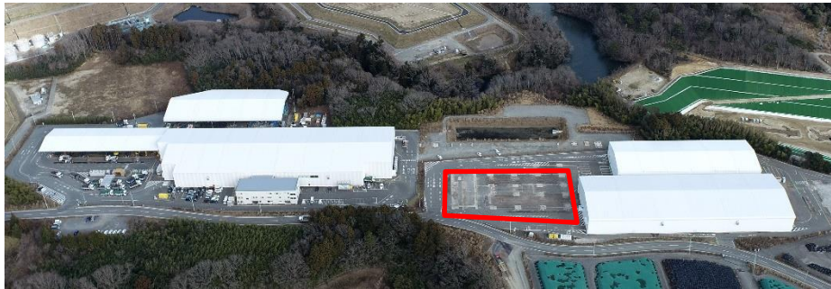
受入・分別施設(一部解体完了:赤枠部分)
