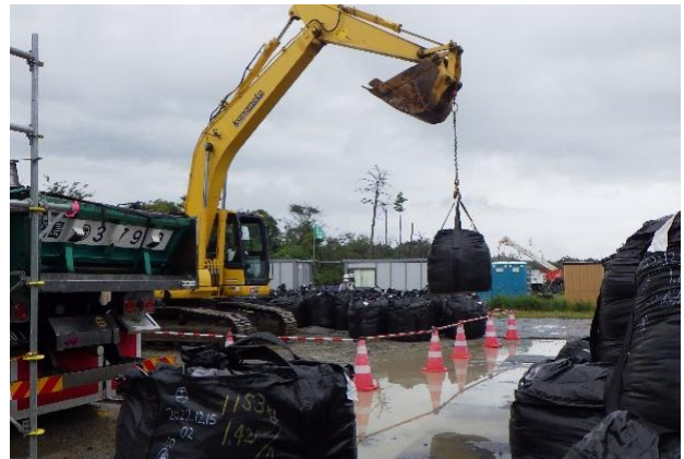
除去土壌等の積込作業
