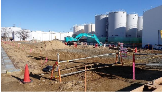
(写真4) 敷地東側の拡張予定箇所の状況
