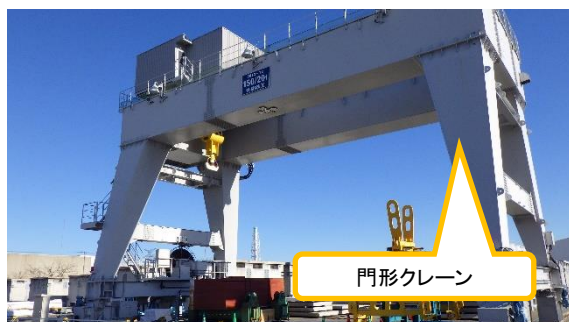
(写真3) 門形クレーンの状況
