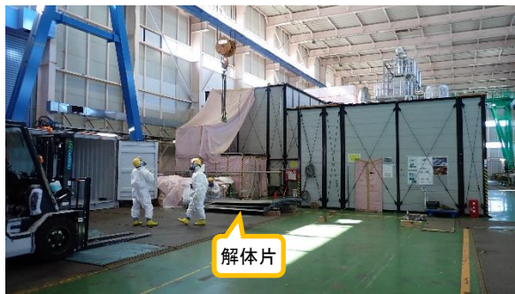
(写真3-2) 除染処理終了後のクレーンによる解体片の仮置き状況
