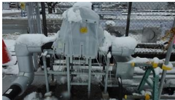
(写真 2-2) ベント弁の雨水浸入防止対策の状況 (今回撮影)
