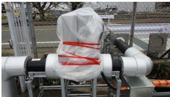
(写真 2-1) ベント弁の雨水浸入防止対策の状況 (令和5年9月8日撮影)
