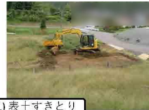
1) 表土すきとり
