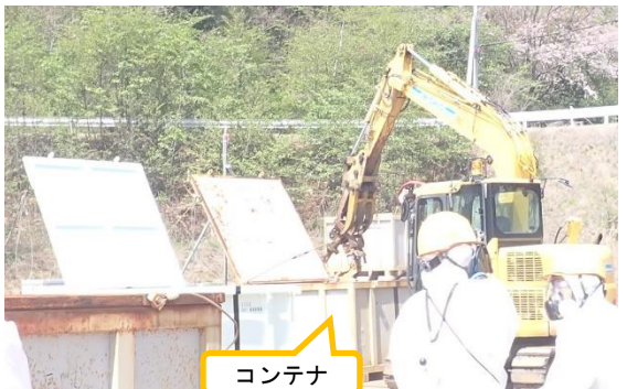
(写真3-2) 詰め替え作業モックアップの状況②
