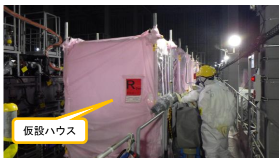
(写真1) 受入タンク周囲に設置された仮設ハウスの状況
