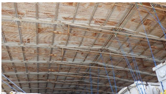
(写真2-2) 一時保管エリアN屋根部の状況
