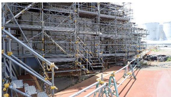
(写真1) 一時保管エリアNの外観
