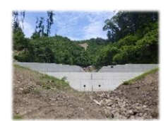
治山施設の整備
