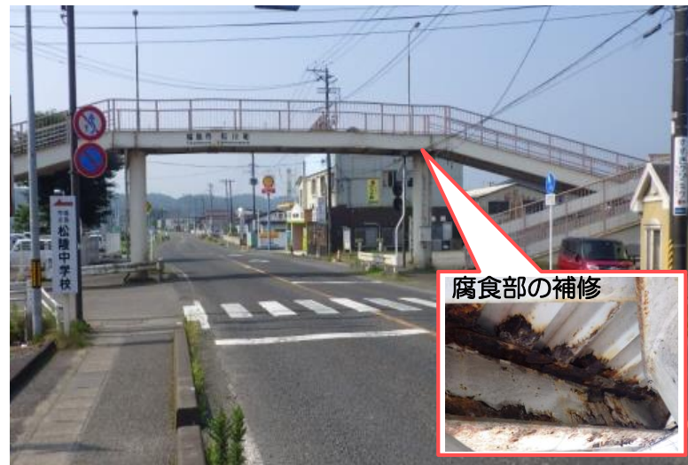
福島安達線 松川横断歩道橋 (福島市)
