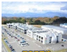
福島県環境創造センター
