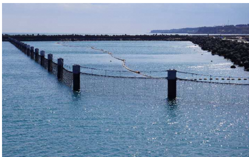
図2-1.東波除堤および1-4号機取水路開渠周辺を囲う状況
