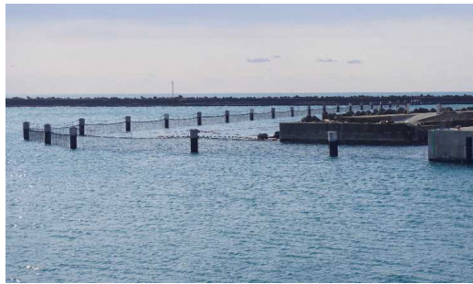
図2-2.1-4号機取水路開渠周辺(出口)を囲う状況
