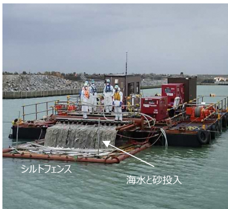
図4.ユニポート台船による1層目の覆砂投入状況
