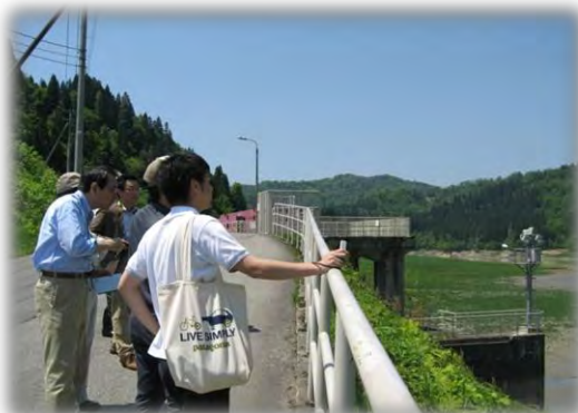
(240527現地調査の様子（上田ダム）)
