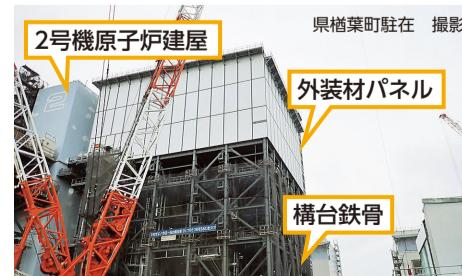
2024~2026年度に燃料の取り出しが開始される予定であり、原子炉建屋の南側に使用済燃料取り出し用構台の設置が進められています。
