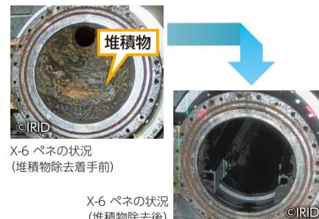
燃料デブリの取り出しを妨げていた原子炉格納容器に通じる作業用の貫通孔(X-6ペネ)内の堆積物について、令和6年1月から除去作業を行い、5月13日に完了しました。
