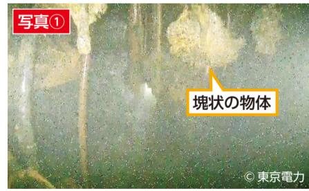
令和6年2月から3月にかけて、小型ドローンを使用した気中部(水で満たされていない部分)における原子炉格納容器内部調査(気中部調査)が実施され、ペデスタル(原子炉圧力容器を支える土台)内壁に大きな損傷は確認されず、コンクリートが残存していること、またCRD(制御棒駆動機構)交換用開口部付近につらら状や塊状の物体があることが確認されました。
